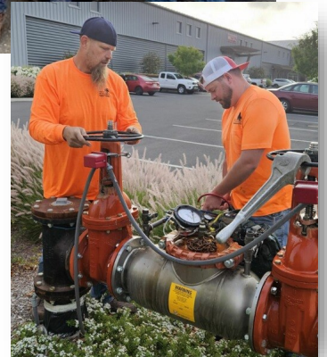
Arriba: el equipo de operaciones de Windsor Water Izquierda: el personal de operaciones de Windsor Water realiza una prueba de contraflujo. Derecha: Operadores de Windsor Water prueban la línea del servicio contra
